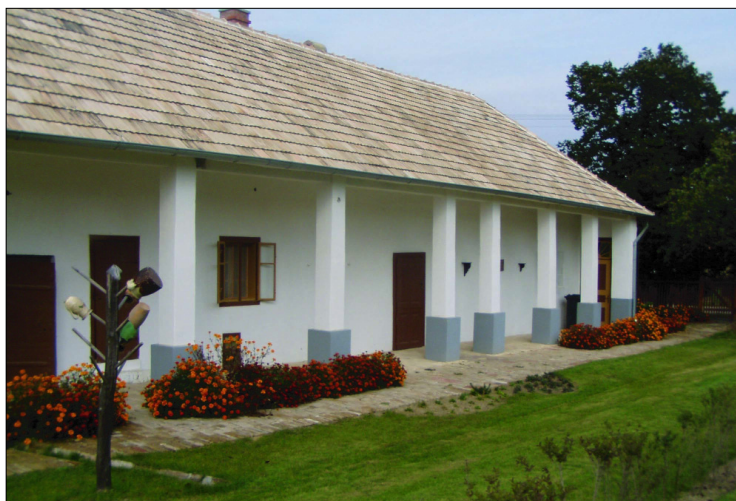
Dvor Obecného domu
